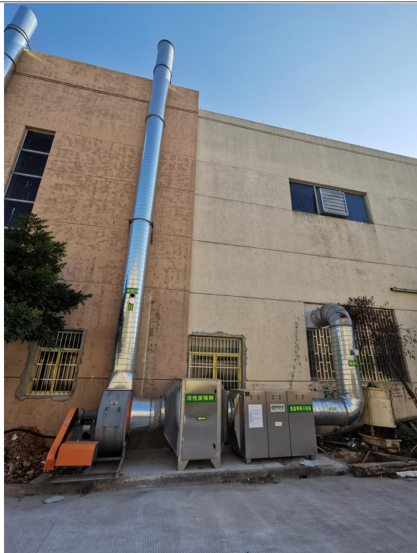
炼塑、发泡废气处理设施（低温等离子+活性炭吸附）
