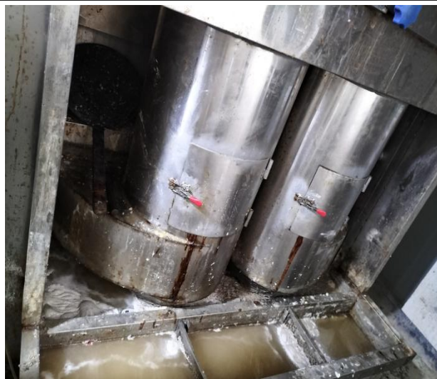
喷漆废气处理设施：过滤棉+活性炭吸附脱附+催化燃烧+15m 高空排放
