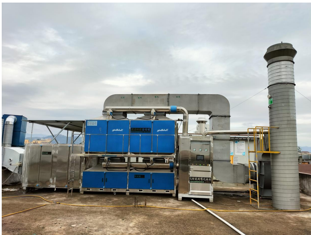
喷漆废气处理设施：过滤棉+活性炭吸附脱附+催化燃烧+15m 高空排放
