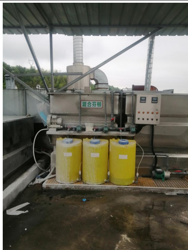
喷漆废水芬顿处理
