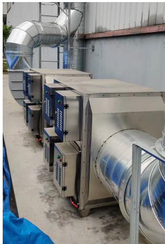
二级静电除油装置（废气处理设施）
