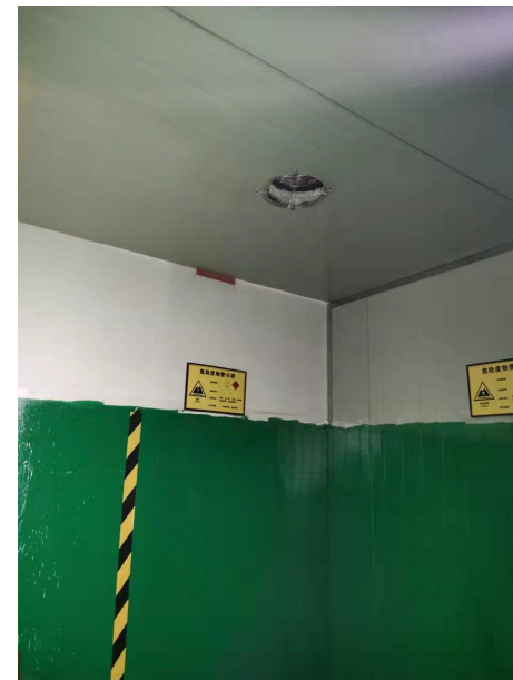
危废仓库废气收集口
